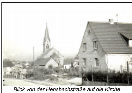
Blick von der Hensbachstraße auf die Kirche.
